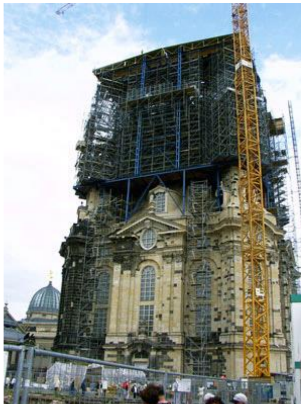
Frauenkirche mit Kuppelgerüst
